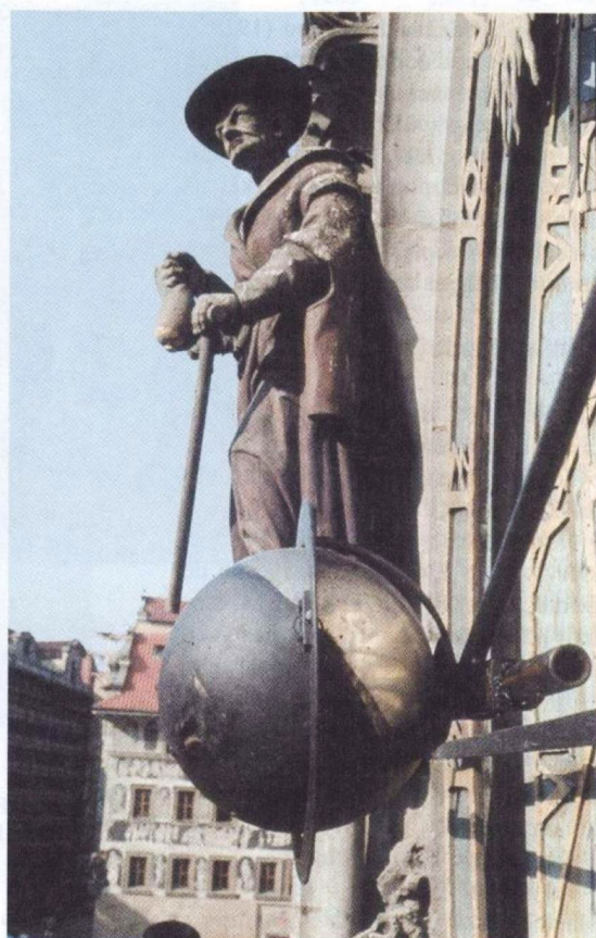
Obr. 6. Detail Měsíce. Zprava k němu přichází tyčka, vymezující jeho polohu na obvodu zvířetníku. (Foto Z. Šíma.)
