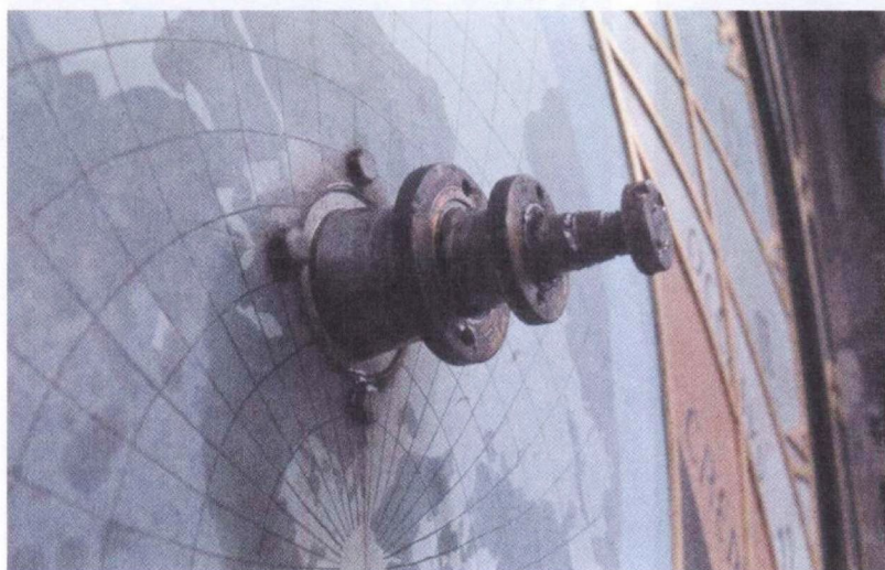
Obr. 17. Vyvedení hlavních kol dutými osami na ciferník orloje. Stav při opravách při sejmutí pohyblivých částí orloje. (Foto Z. Šíma.)
